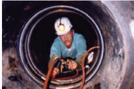
Realizar Prueba de presión del Sello
